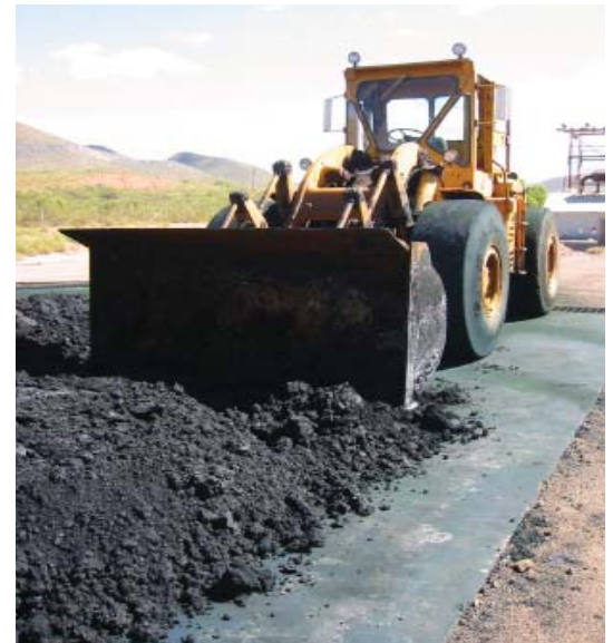
Los procesos recuperan productos metálicos comercializables que pueden ser vendidos para compensar los costos del tratamiento de aguas
